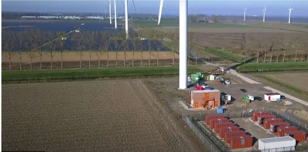
Figur 12. Bild från Vattenfall.se, hybridpark Haringvliet i Nederländerna, där vindkraft kombineras med solceller och batterilagring.
