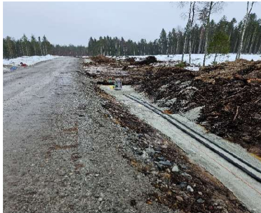
Figur 16. Kabelförläggning, Munkhyttan vindpark, Lindesberg kommun.
