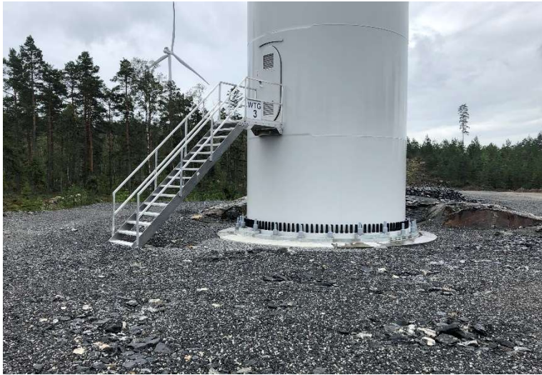
Figur 11. Ett färdigt fundament, merparten dolt under mark.
