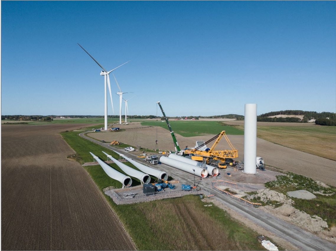
Figur 14. Bilden visar arbetet då turbinerna restes. Ytorna för mellanlagring av bladen ses som grusade ytor, även dessa är nu insådda med gräs.
