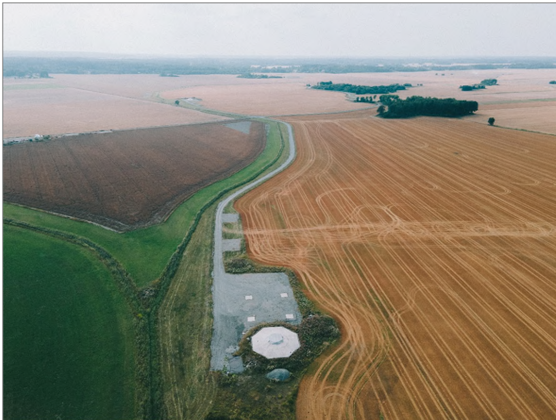
Figur 13. Tillfartsväg, kranyta och fundament för ett av vindkraftverken.
