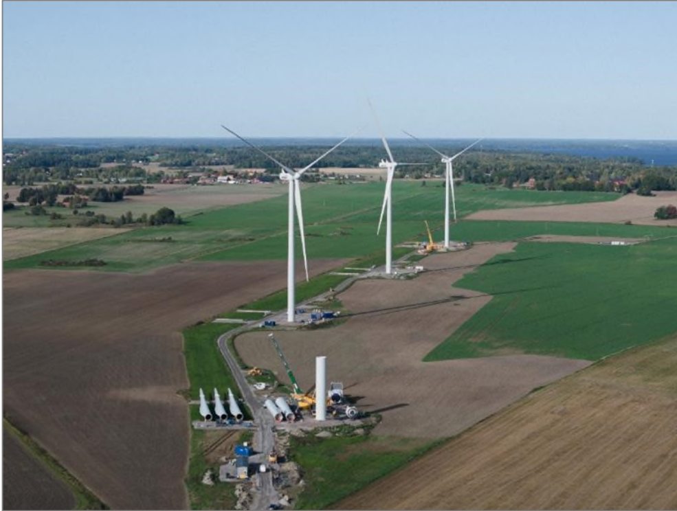
Figur 2. Sundby vindpark under uppförandet av vindkraftsverken. Foto: Cloudberry Wind AB
