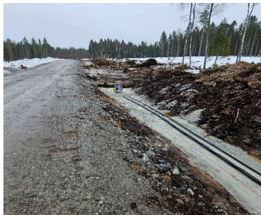
Figur 13 Kabelförläggning, Munkhyttan vindpark, Lindesberg kommun
