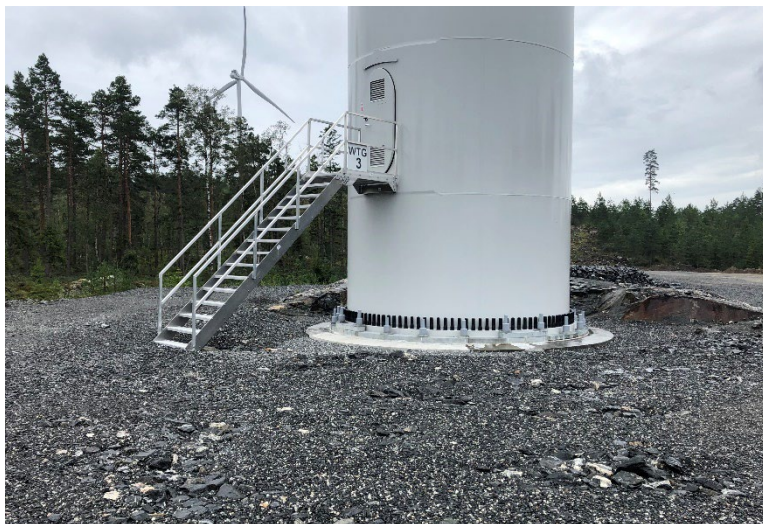
Figur 8 Ett färdigt fundament, merparten dolt under mark
