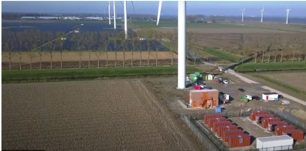
Figur 9 Bild från Vattenfall.se, hybridpark Haringvliet i Nederländerna, där vindkraft kombineras med solceller och batterilagring
