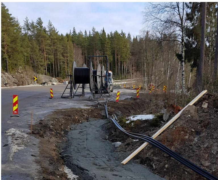
Figur 13 Kabelförläggning, Marker Vindpark, Norge
