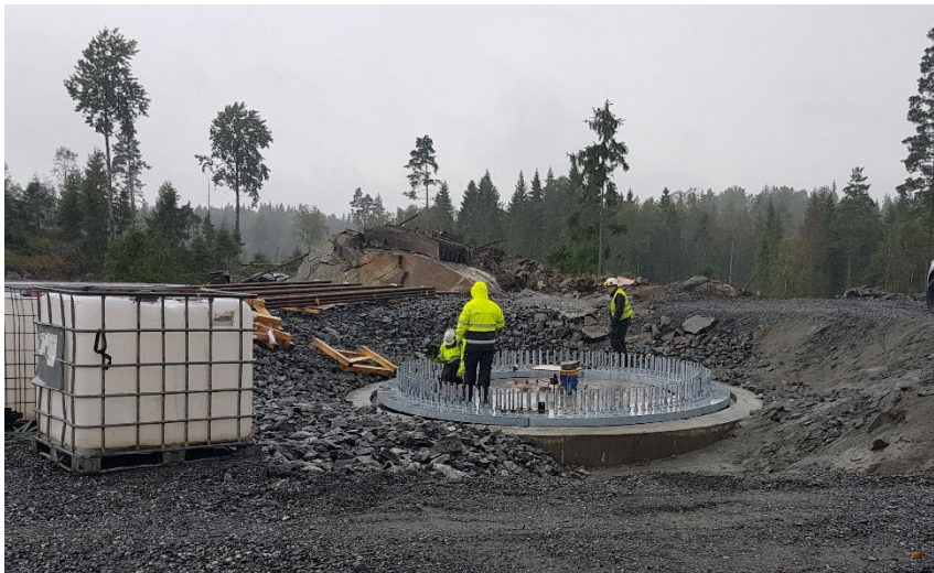
Figur 8 Bergsförankrat fundament, Marker Vindpark, Norge
