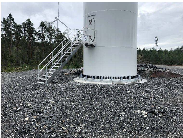
Figur 9 Ett färdigt fundament och ingång till tornet
