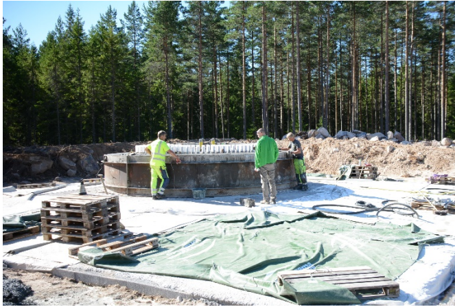
Figur 7 Gravitationsförankrat fundament, Sättravallen vindpark, Kristinehamn
